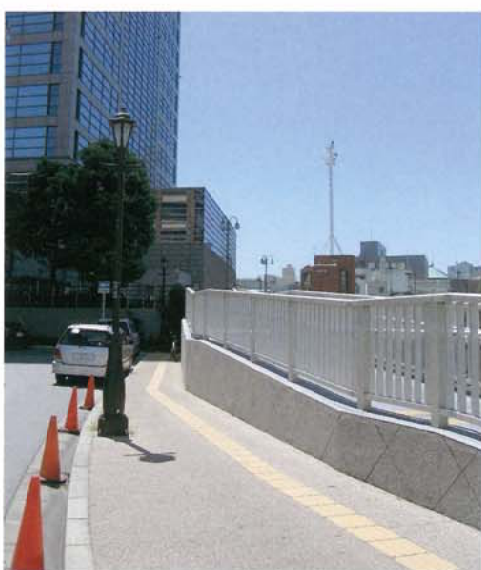
スロープ造成
