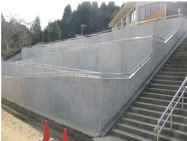
スロープ擁壁は、階段部や安全スロープ構築のような壁面天端が急斜の場合などに活躍するL型擁壁で、逆L型擁壁としても使用することが可能なデザインとなっております。
