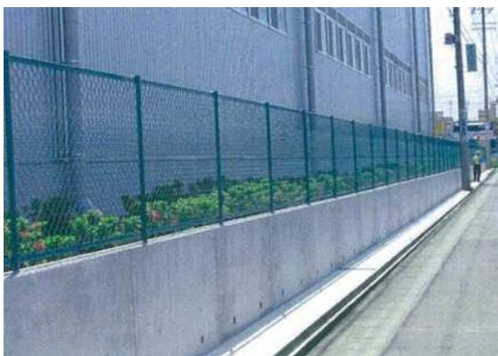
CLP-Fは、フェンス取付孔を擁壁本体に一体形成した施工性に優れたL型擁壁です。
