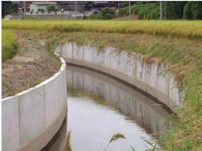
背抜き構造の軽量化により安価な水路を提案します。
