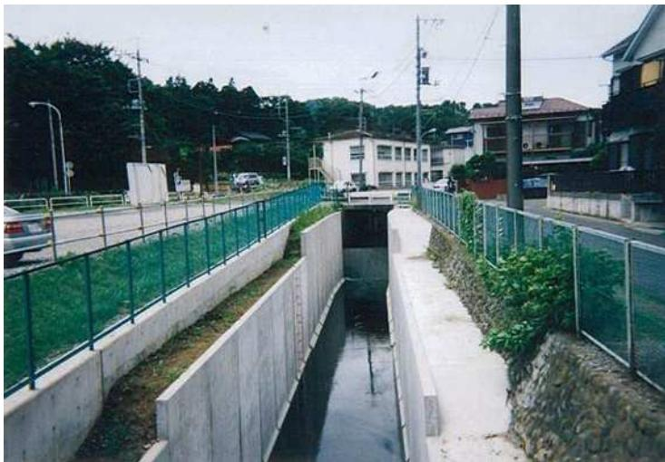
現場打ち部の調整で水路幅を自由に設定できます。右・左岸の高さが異なっても施工可能です。底面浸透浄化水路も可能です。
