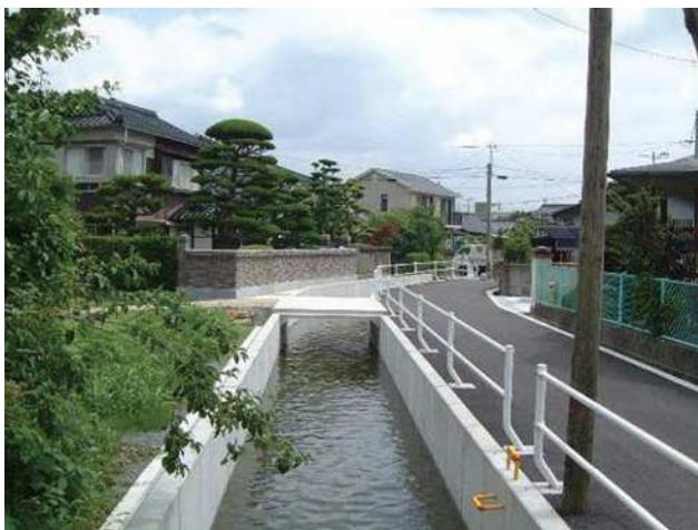
パワーUは、CY型パワーBOXカルバートと同じ外幅寸法になっているので、暗渠・蓋かけ水路という構成になる流路計画現場に最適な三面水路製品です。
