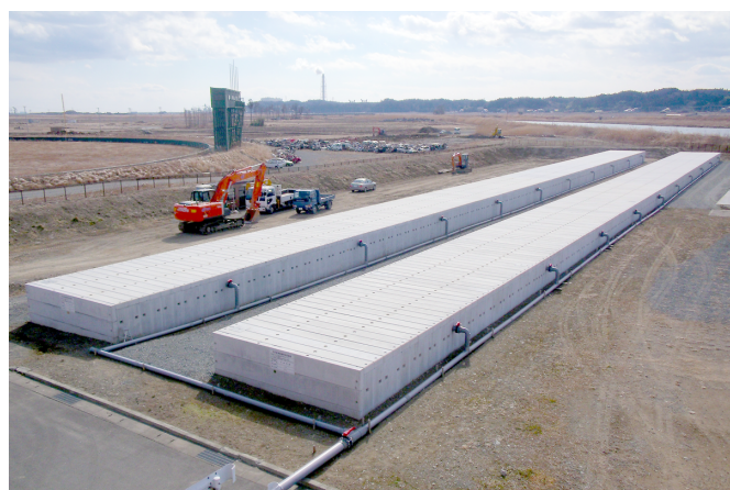
◎下水処理汚泥保管庫／南相馬市下水処理場
