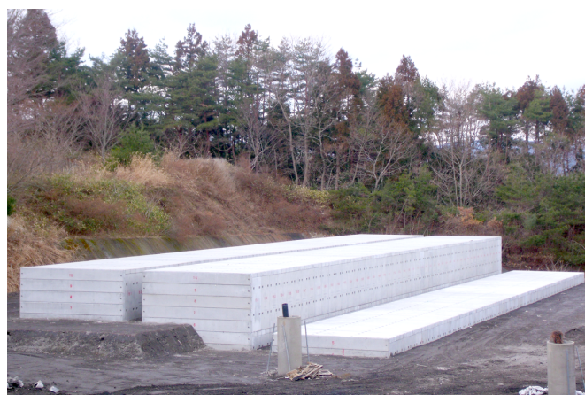
◎焼却灰保管庫(二段式)／南相馬市クリーンセンター
