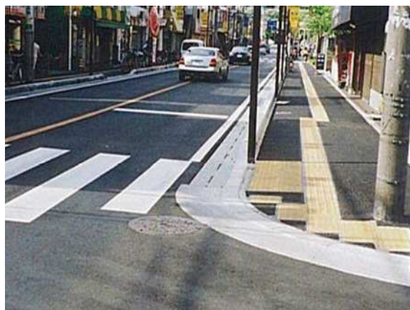
バリアフリー整備工事 採用例
