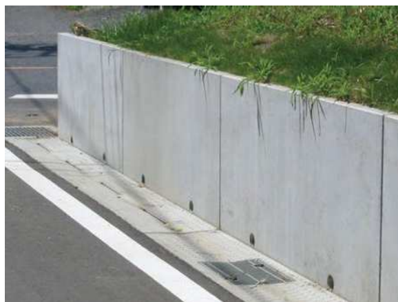
土留パネル施工例
